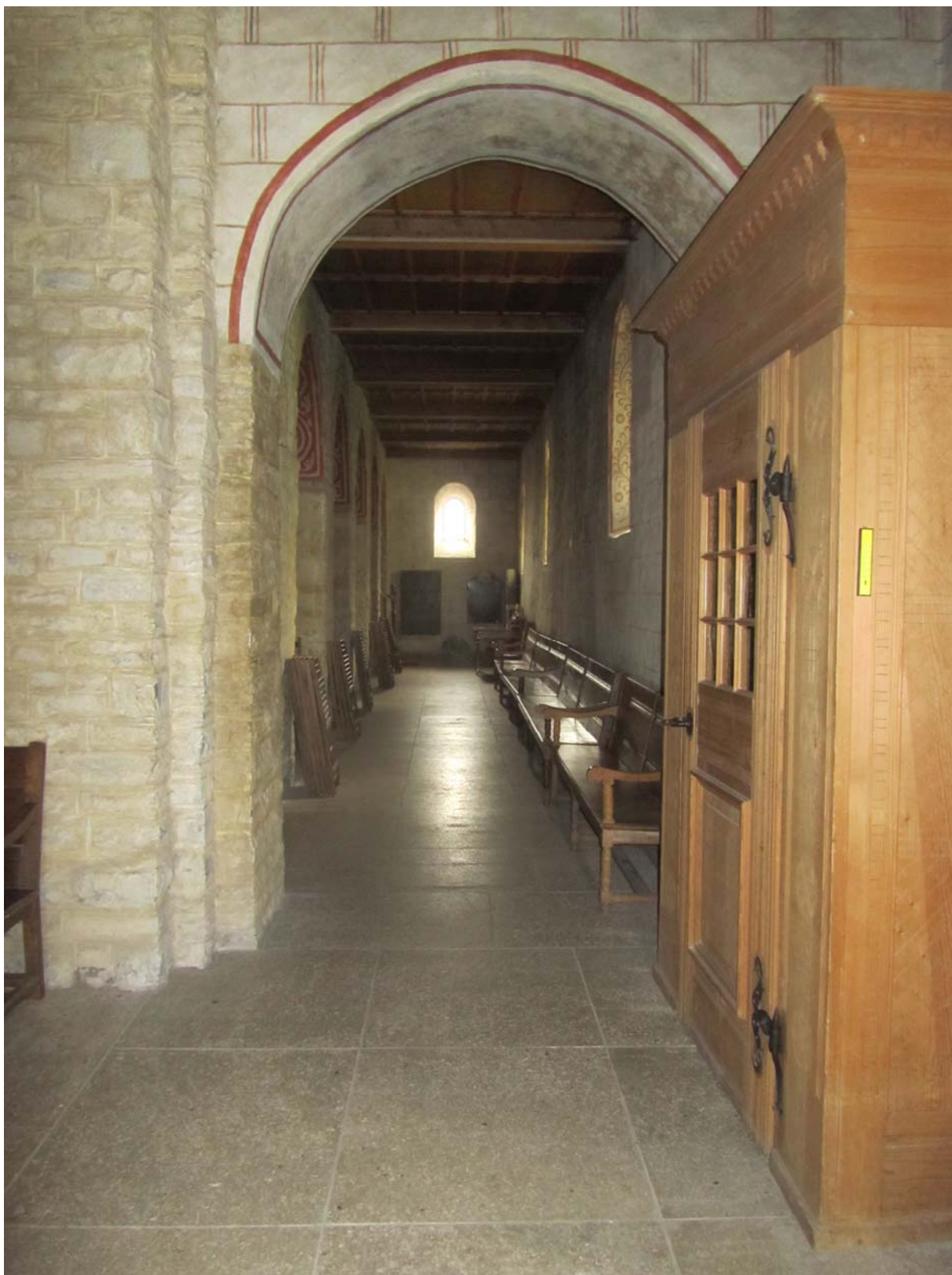
Couloir latéral côté route.
